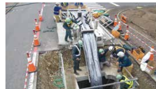
アルファライナー工法 φ1350mm施工現場(更生材はドイツより輸入)
