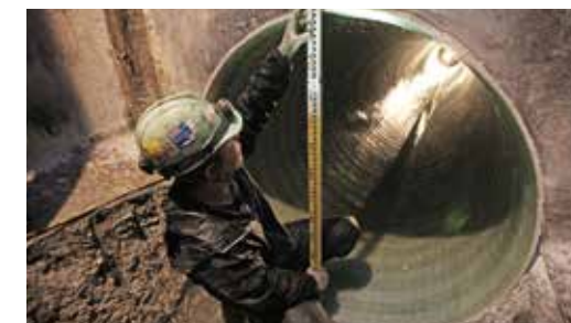
アルファライナー工法 φ1350mm施工現場(更生材はドイツより輸入)
